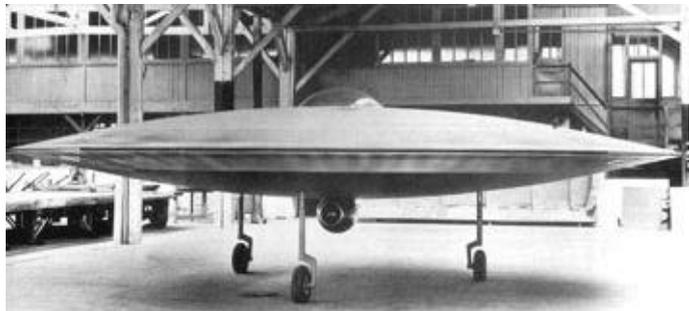
La maquette au 3/5<sup>ème</sup> en bois du projet "d'aérodyne à ailes multiples" RC-360 avec les ailes en rotation. L'engin ne quitta jamais le sol.
