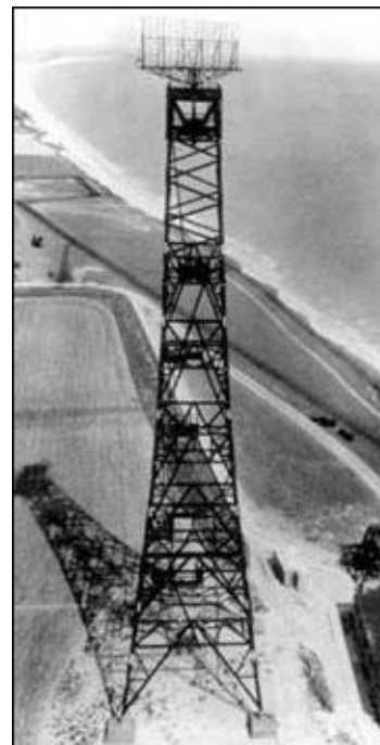
Ce pylône du dispositif "Chain Home" supporte une antenne radar rotative. L'opérateur peut suivre une cible dans son faisceau. MM
